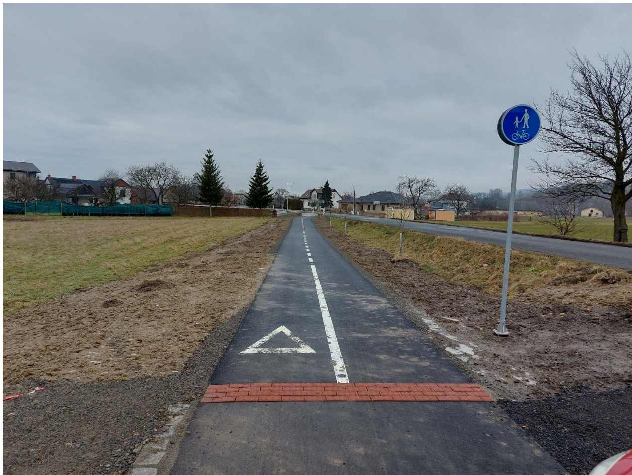
Výstavba cyklostezky směr Paseka Sanatorium
