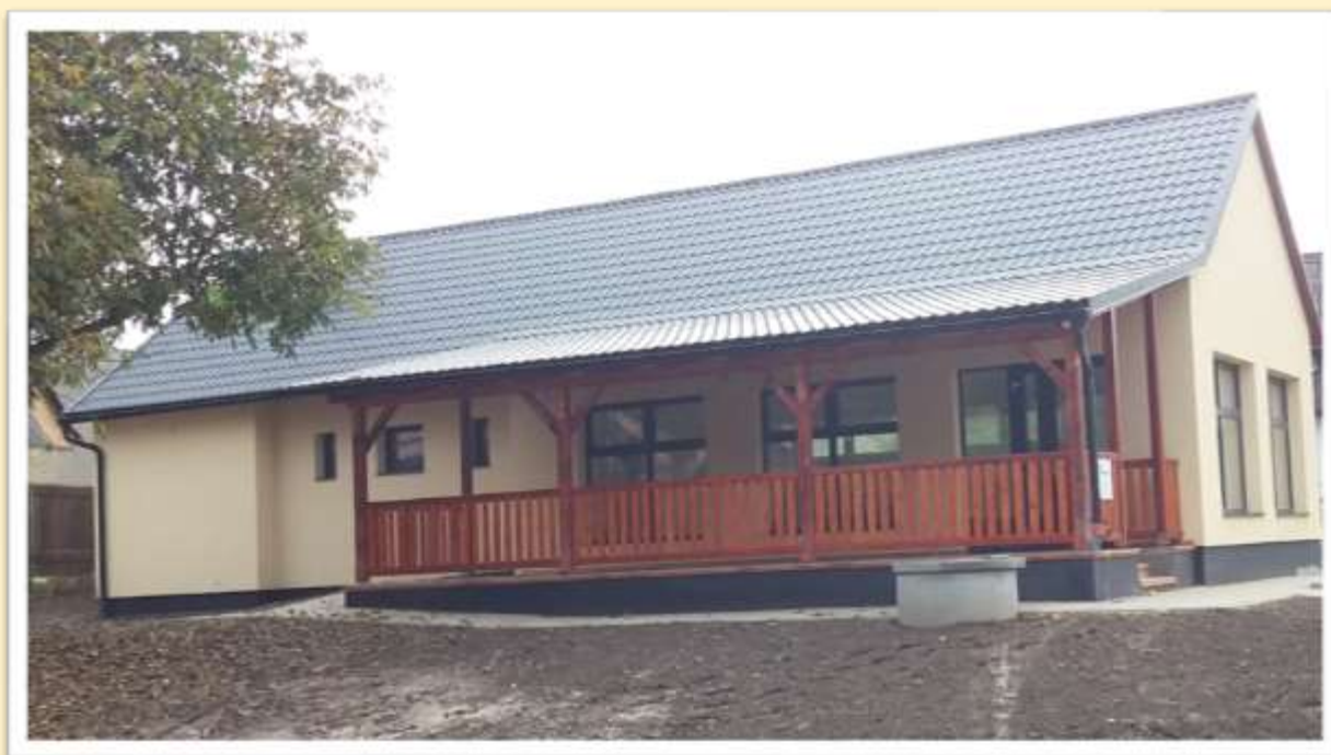
Výstavba nového obchodu smíšeného zboží v Plinkoutě
