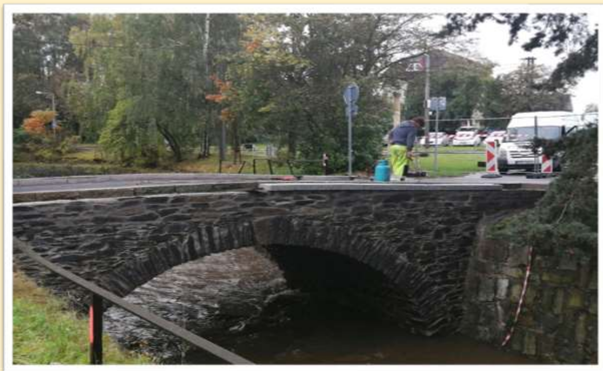
Rekonstrukce mostu u pošty
